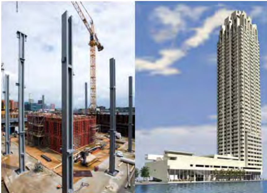
Kolommen onderbouw woontoren New Orleans
