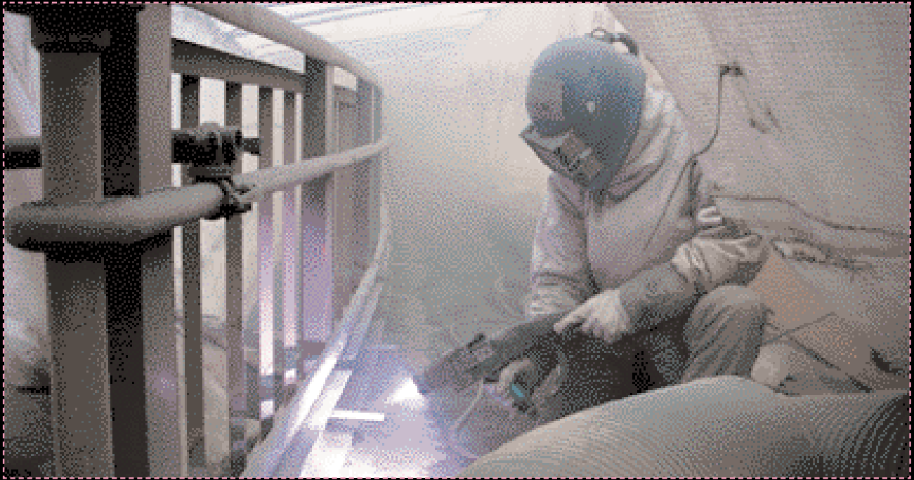
Een nieuwe manier van conserveren is aluminiseren: het bespuiten van het staal met een beschermend laagje aluminium.
