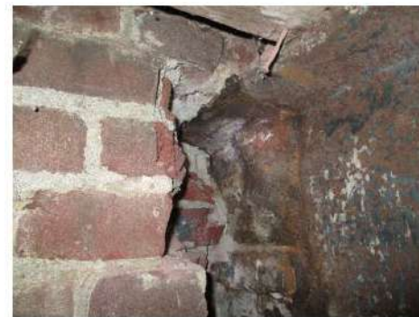
Locatie profiel : C; Etage 2 Fotonummer :399 Bevinding : Visueel geen materiaalafname zichtbaar.
