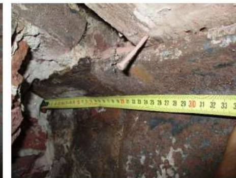
Locatie profiel : C; Etage 2 Fotonummer :400 Bevinding : Visueel geen materiaalafname zichtbaar.
